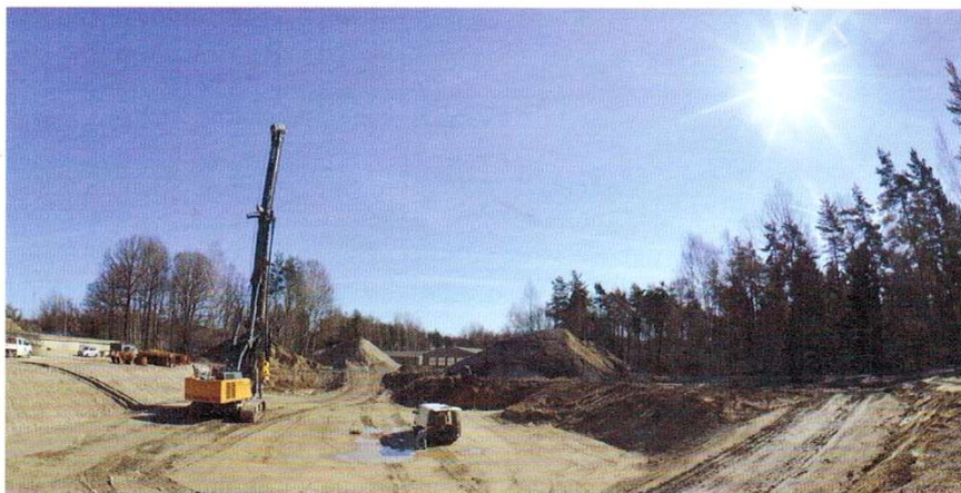
4c Tiefengründung für das tonnenschwere DRESHDYN-Experiment (HZDR / Matthias Rietschel)
